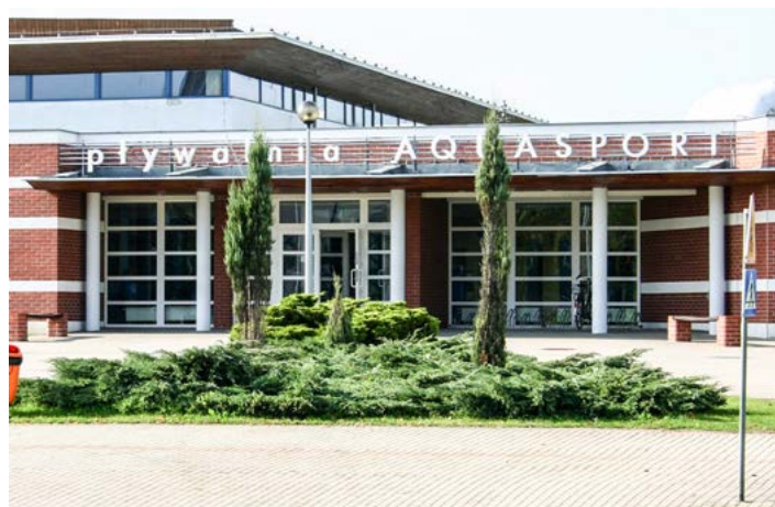
Termomodernizacja pływalni Aquasport
