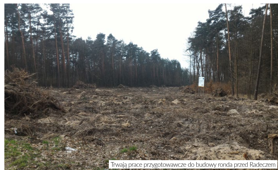
Trwają prace przygotowawcze do budowy ronda przed Radeczem
