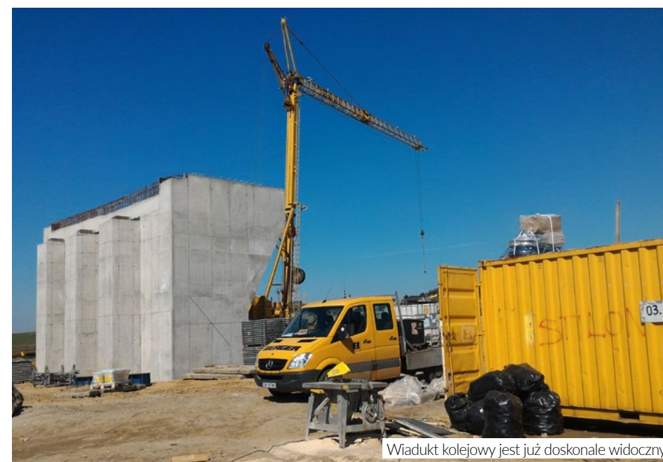
Wiadukt kolejowy jest już doskonale widoczny
