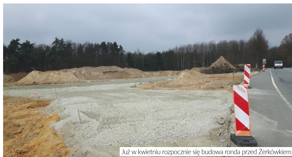
Już w kwietniu rozpocznie się budowa ronda przed Żerkówkiem
