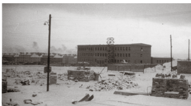
Osiedle Fabryczne, najprawdopodobniej zima przełomu lat 1958-59. W środku kadru w budowie gmach Szkoły Podstawowej nr 5, która powstawała jako jedna ze „szkół – pomników tysiąclecia Państwa Polskiego”. Na pierwszym planie widać także budowane domy jednorodzinne na zbiegu ulic Małopolskiej i Wyścigowej. Zdjęcie ze zbiorów pani Małgorzaty Stangenberg.
