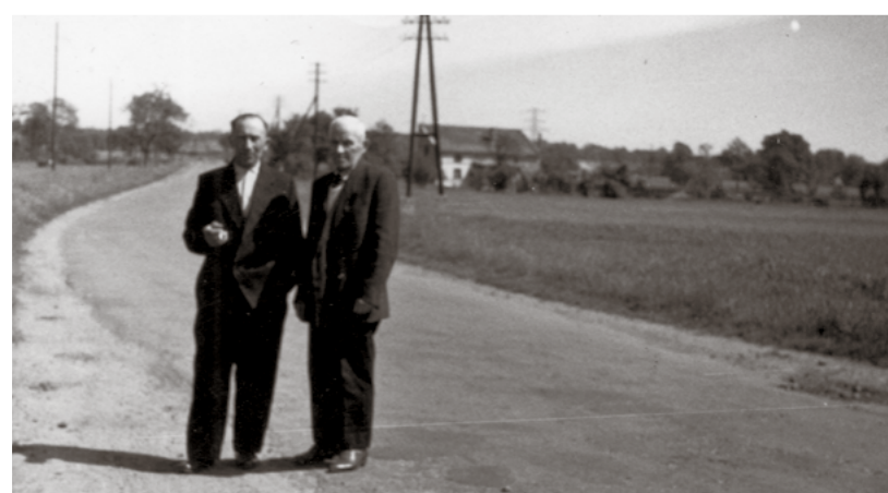
Ulica Urzaska w roku 1968. To zdjęcie doskonale pokazuje jak bardzo zmieniła się ta część Brzegu Dolnego. Przed rozbudową Rokity osiedle Krańsko było cichą wsią leżącą dość daleko od fabryki i samego miasta. Rozwój zakładów chemicznych spowodował wyburzenie części domów i zupełnie zmienił okolicę: dziś na polu po prawej stoi olbrzymia rozdzielnia elektryczna. Zdjęcie nadesłała pani Małgorzata Stangenberg.
