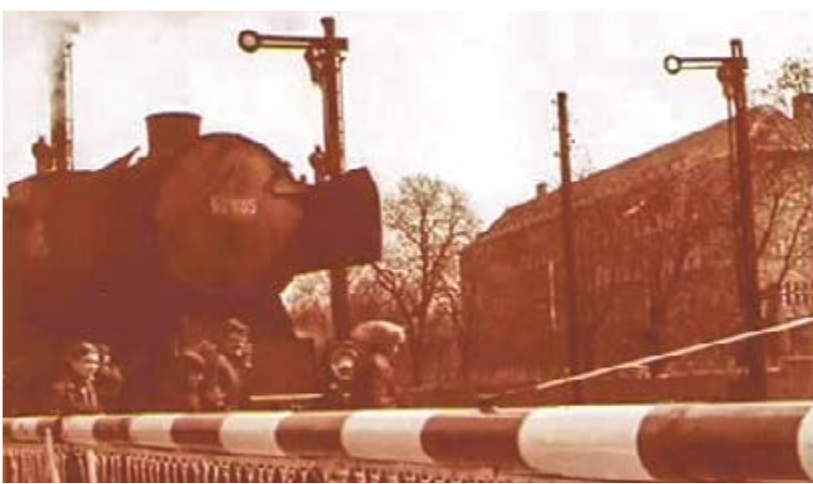
Do połowy lat 70. w miejscu dzisiejszej „kładki” był zwykły przejazd kolejowy. Ze względu na spory ruch pociągów przejazd był przeważnie zamknięty. Przechodzenie wiązało się z ryzykiem złapania przez dzielnych mundurowych ze Straży Ochrony Kolei. Zdjęcie z archiwum pana Mieczysława Stanowskiego.
