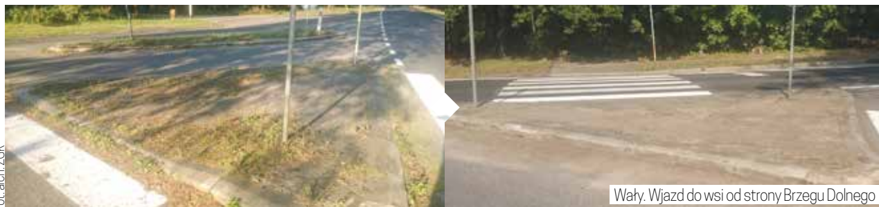
Wały. Wjazd do wsi od strony Brzegu Dolnego
