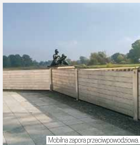
Mobilna zapor przeciwpowodziowa w trakcie montażu.
