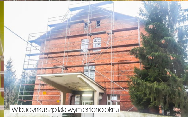
W budynku szpitala wymieniono okna
